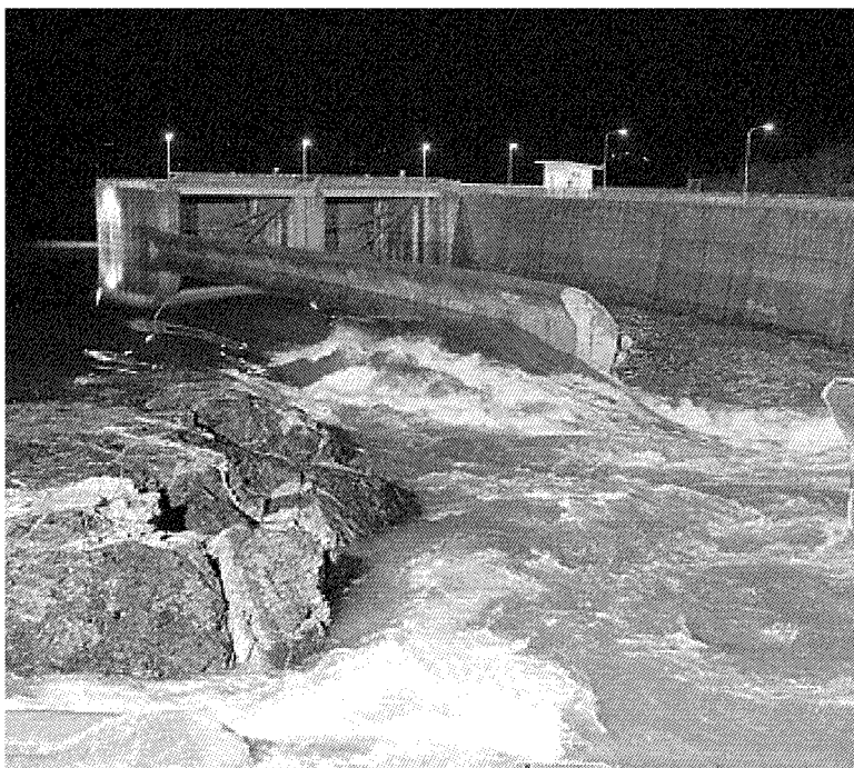
DIGA La furia dell'acqua del 29 dicembre 2010. Oggi l'invaso di Montedoglio fa paura perchè appare sotto il livello di sicurezza
